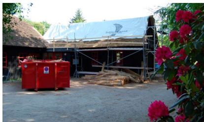
- Fra arbejdet med det nye stråtag. (Foto: Kaj Kaspersen)
